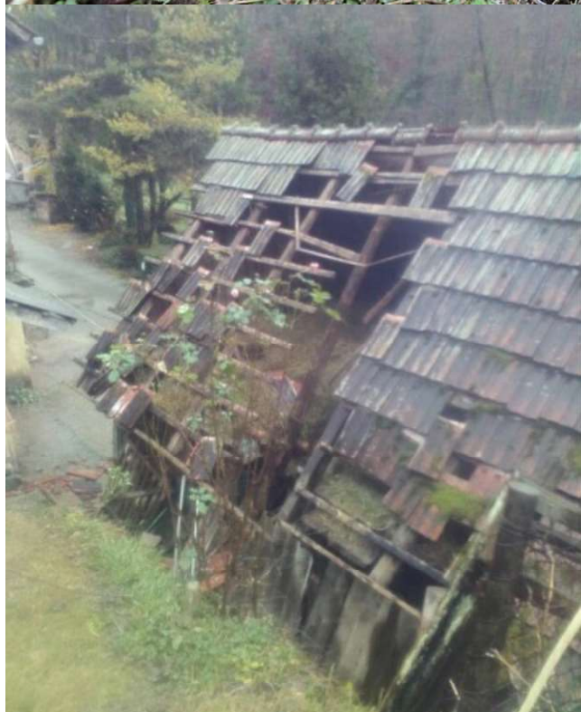
Slika 2 Fotografije poškodb objektov in zemljišč po trku s skalnim blokom dne 26.11.2018 (Vir: Slovenske novice, https://www.slovenskenovice.si/iz-tiskane-izdaje/clanek/skale-jim-luknjajo-strehe-121598 ).
